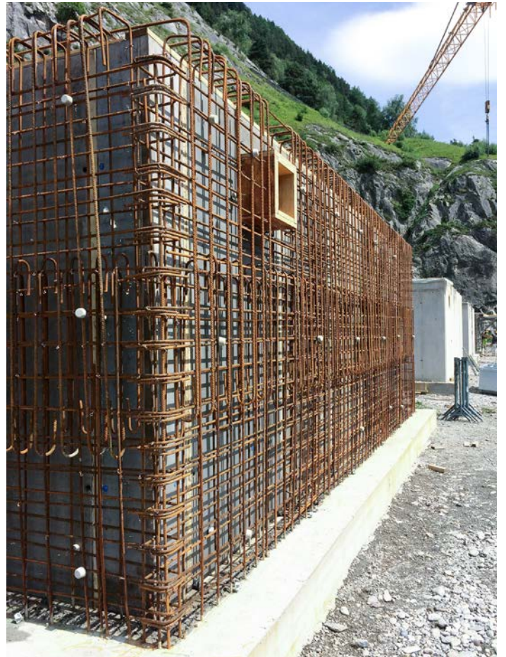
Module werden vor Ort aus stahlbewehrtem Beton gegossen.
