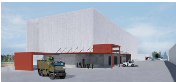
Rothenburg ist einer von schweizweit vier Containerstützpunkten und hat eine Kapazität für 600 Container.
