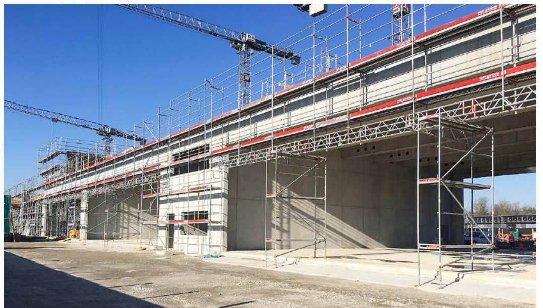
Ab Oktober ziehen die Drohnen in die neue Halle ein.
