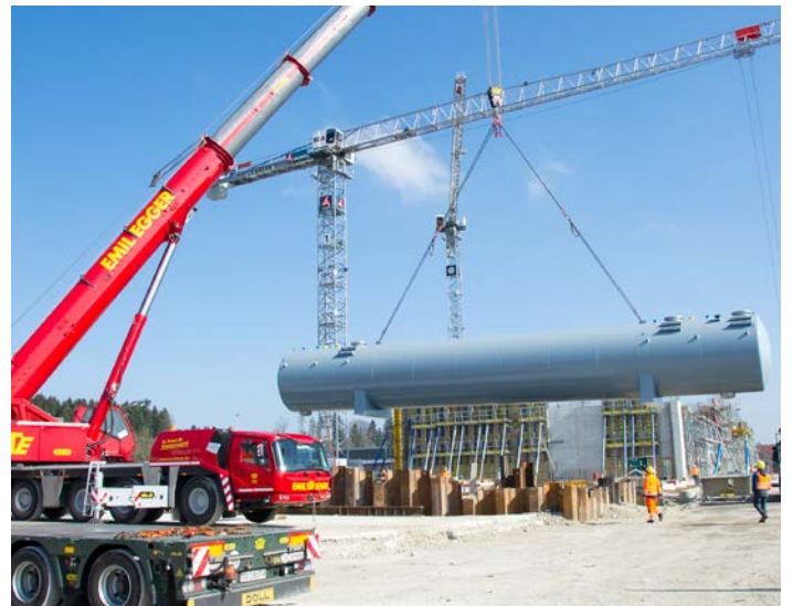
Einbau der Tanks mit Rohrleitungen in die Flugzeugboxen.
